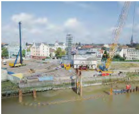
Ertüchtigung der Kaje im Nachgang zu den Abbrucharbeiten
