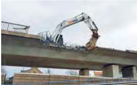
Abbruch der ersten Fahrbahn
