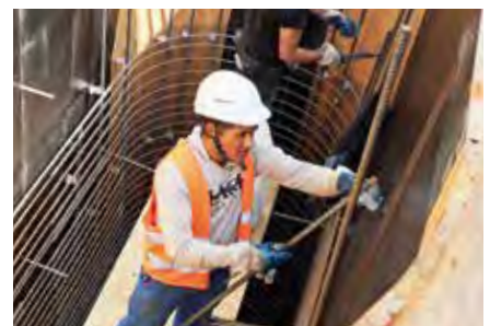
Einbau Bewehrung Pfeiler
