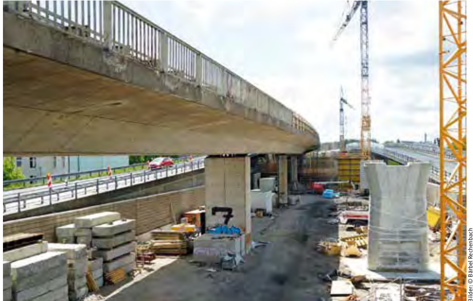
Baustraße zwischen alter Brücke und neuen Betonpfeilern
