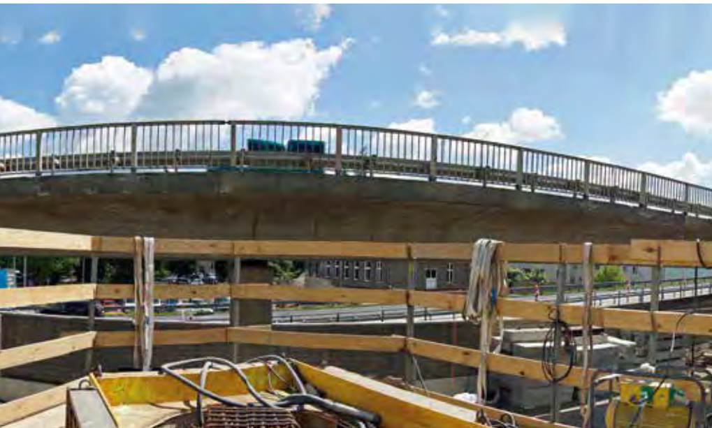
Absturzicherungen am Betonpfeiler
