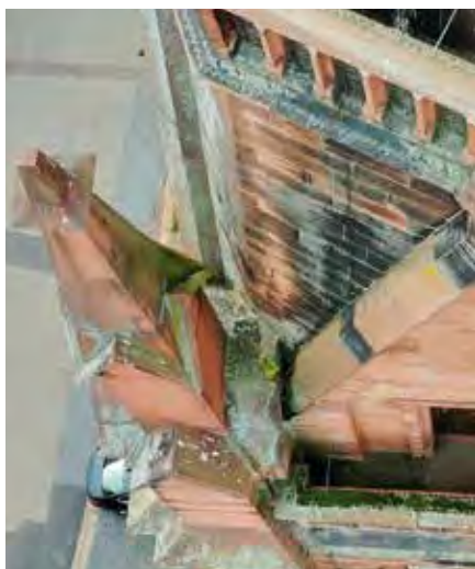
Baumtrieb hinter den Fialen des Kirchturms
