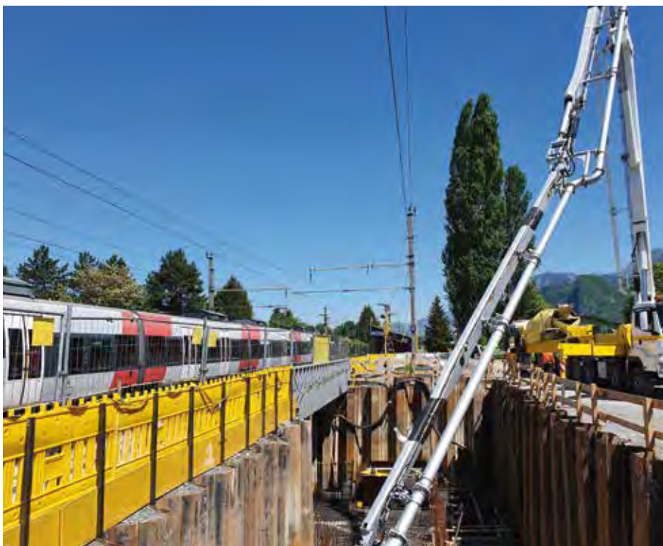
PTLS-Systeme sind mit vielen Baumaschinen kompatibel, hier eine Betonpumpe mit der automatischen, GPS-gestützten Hub- und Schwenkbegrenzung „LogPos“.
