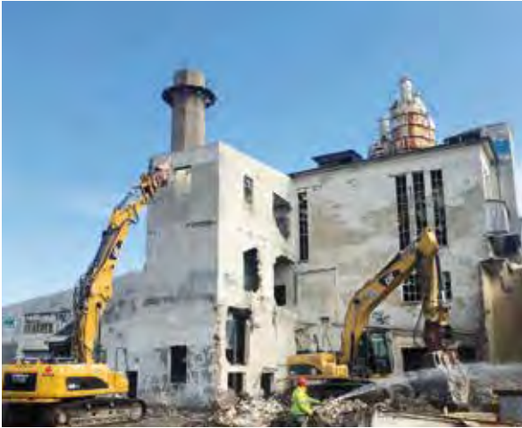
Abbrucharbeiten an der Kalksandsteinfabrik
