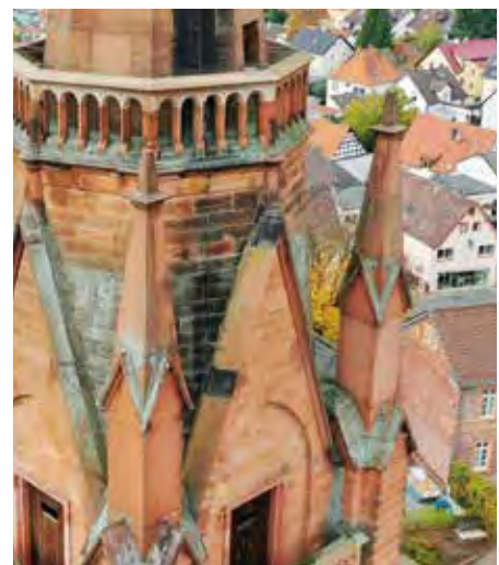
Verfärbungen am oberrheinischen Sandstein im Bereich des Kirchturms/Blitzschutzsystem
