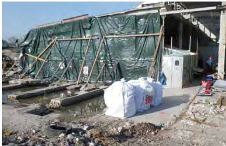
Unterdruckhaltung des Schwarzbereichs zur Härtekesselsanierung
