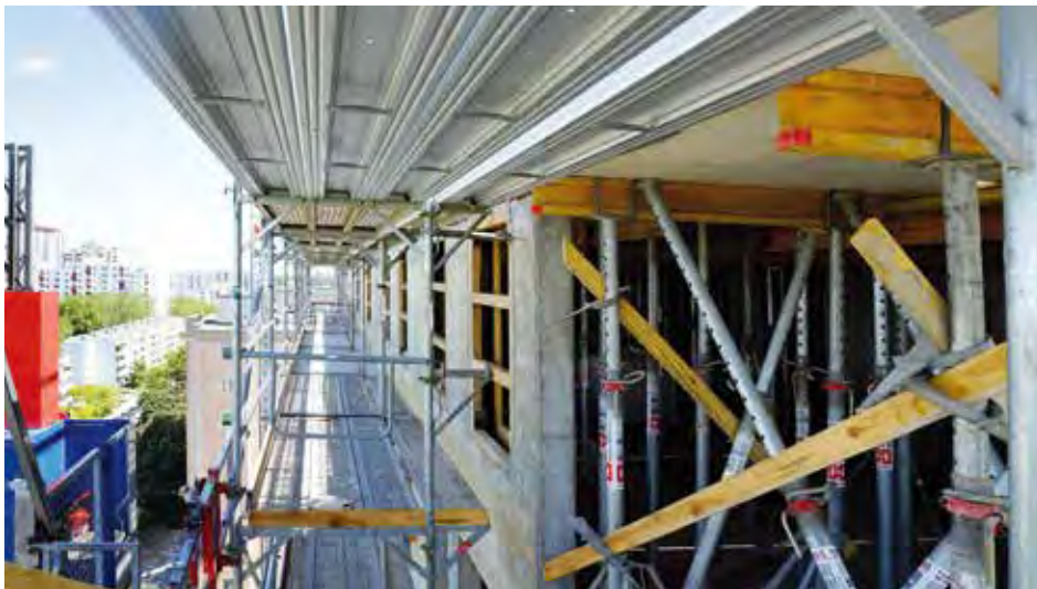
Bild oben und Mitte: Bauaufzug mit Zugang zu den Geschossen
