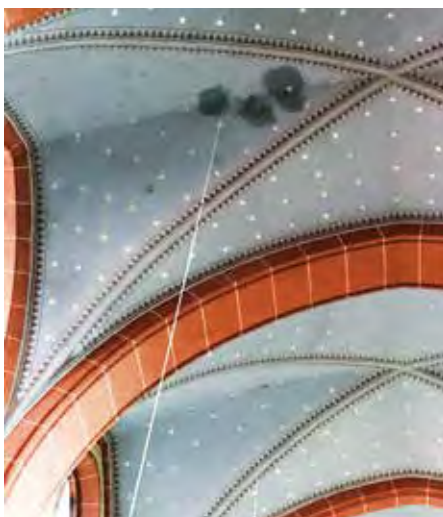
Wasserflecken sind an mehreren Stellen im Gewölbe deutlich sichtbar.
