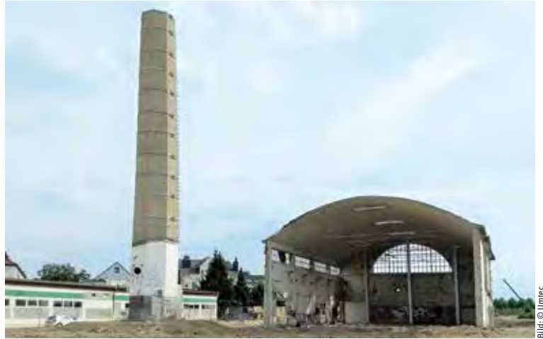
Endzustand der denkmalgeschützten Gebäudeteile der Kalksandsteinfabrik nach Abbruch
