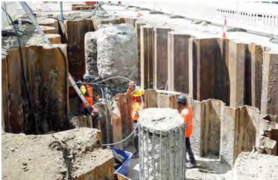
Rückbau der Fundamente
