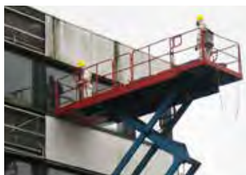
Sanierung der asbesthaltigen Fassade des Verwaltungsgebäudes
