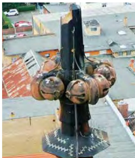
Unwetterschaden: Ansicht der Bruchkante der Kirchturmspitze
