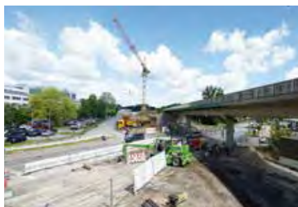
Blick auf Bau des Widerlagers stadteinwärts
