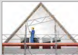
Systemimmanenter bzw. systemintegrierter Seitenschutz im Gerüst
