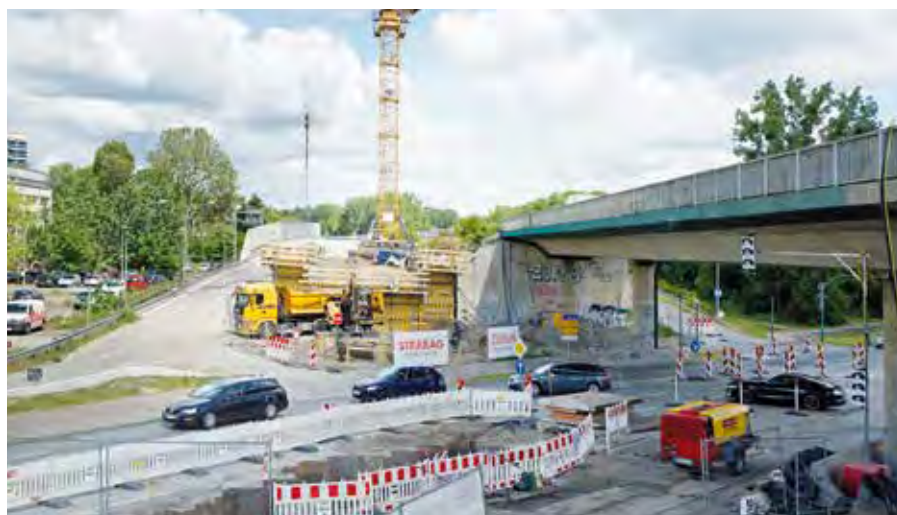
Sicherungen im Straßenbereich
