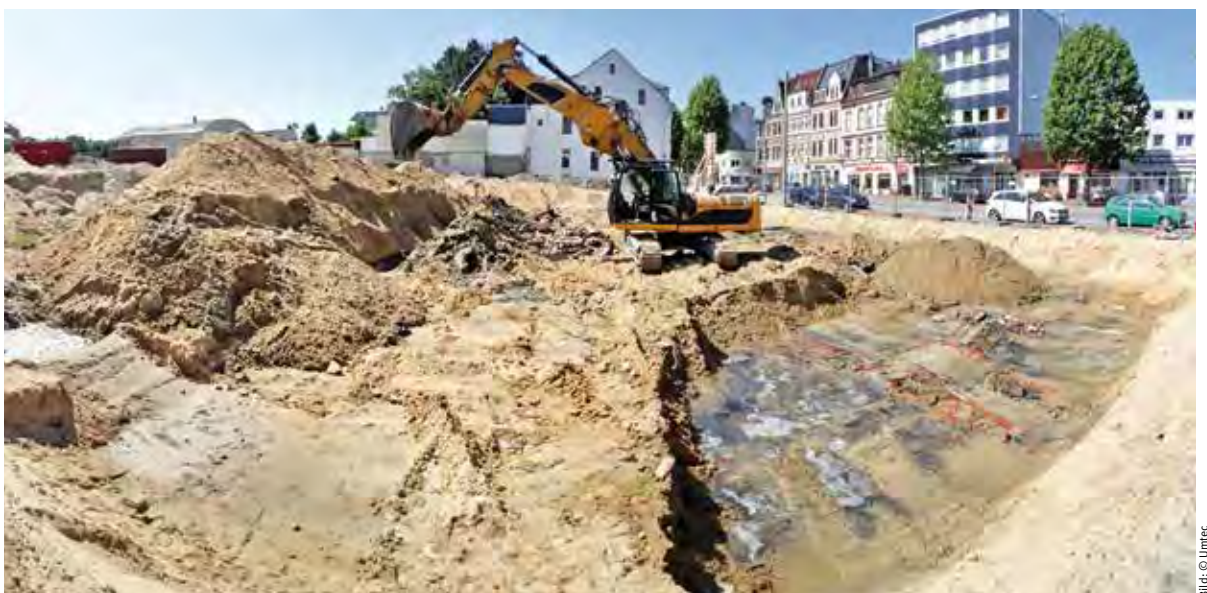
Altlastensanierung auf dem Abbruchgelände
